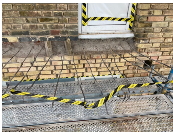
Figur 1: Armeringsjärn återanvänds till nya betongplattan
